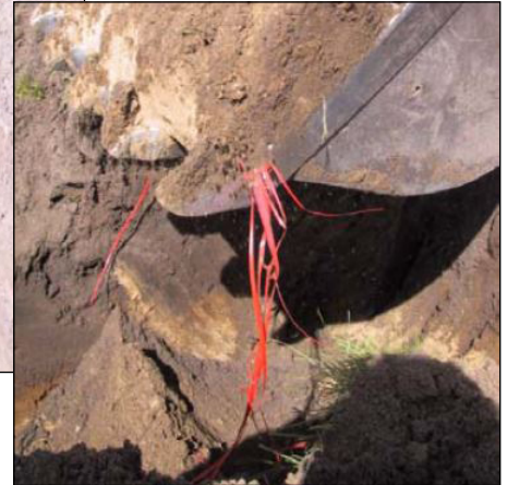
Verkon rakenne tarttuu hyvin kauhaan ja tulee näkyviin.
