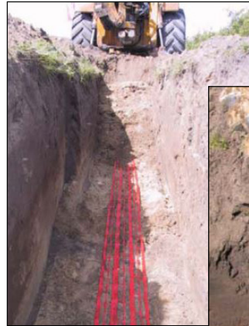
Signaalilanka on teipattu verkon keskelle, jolloin sen saa helposti esille verkkoa jatkettaessa.
